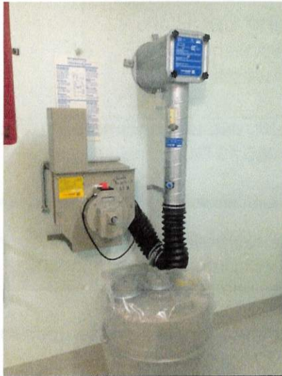
Überdruck-Ventil (UeV)
