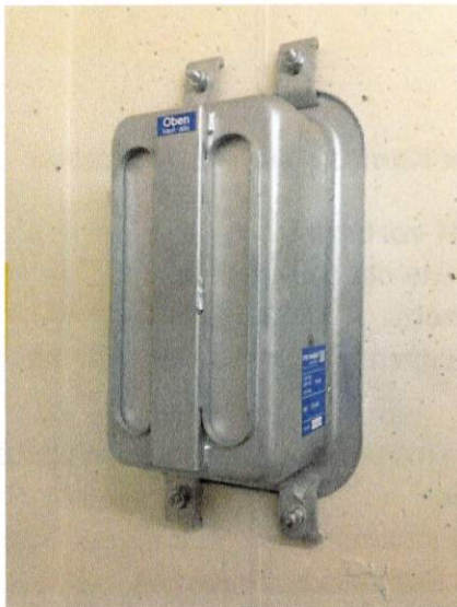
Überdruck-Ventil (UeV)
